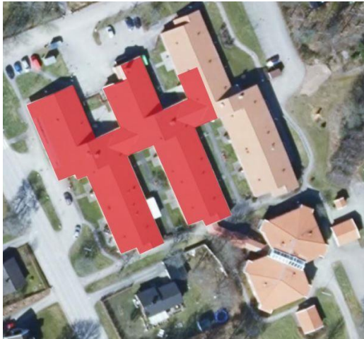
Kosta Servicehus, Rödmärkning visar del av huset som utnyttjas idag.
